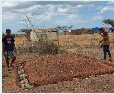
01/02- Début de la construction. Tio Chichi, notre maître de construction prépare le terrain avec son équipe (pierres et sable pour aplanir le terrain et délimiter la zone de travaux)
